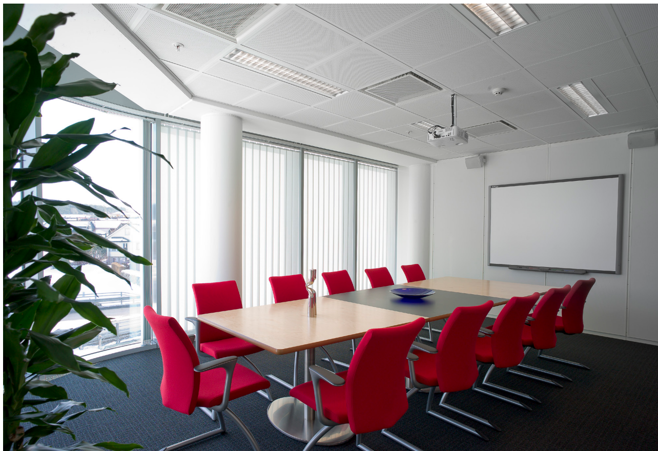
Billede 3. Mødelokale, aktive Plexus-kølebafler med separat reguleret belysning.
